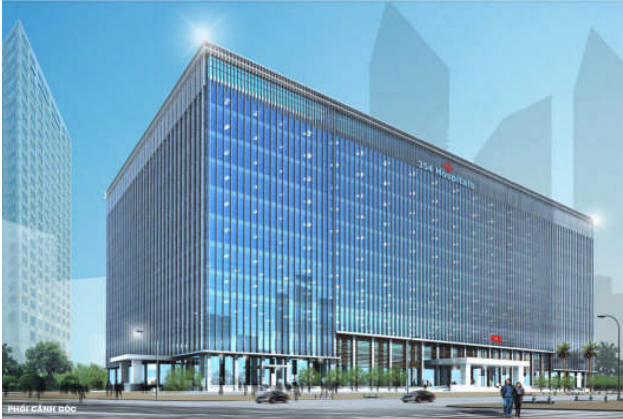
CÔNG TRÌNH: BỆNH VIỆN 354/TCHC
