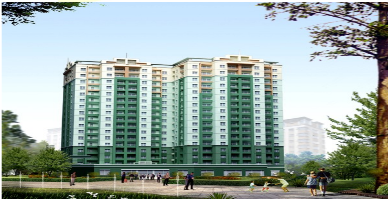
DỰ ÁN: NHÀ CHUNG CƯ CAO TẦNG VĨNH HOÀNG (CTI.1-1A VÀ CTI.1-1B)
